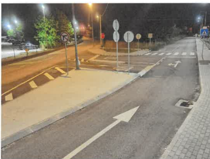
Requalificação Rua da Barra
