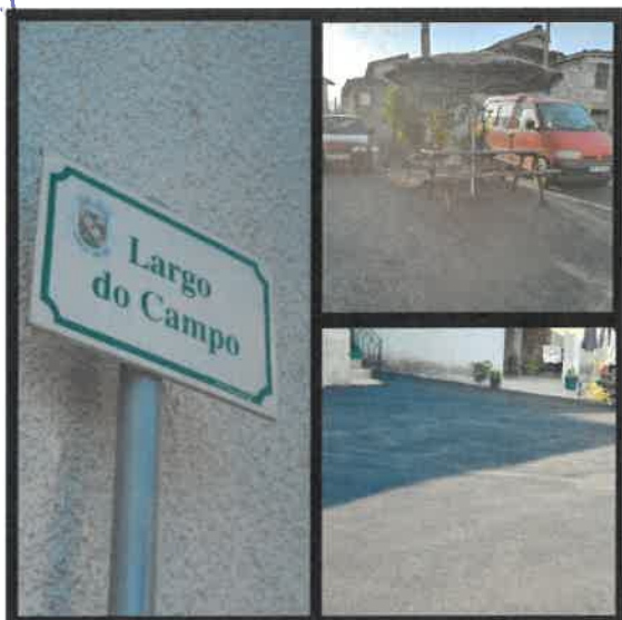
Pavimentação: Largo do Campo
